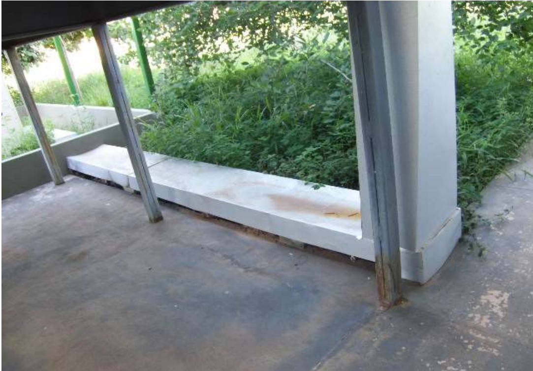
Figura 10 Saída tubulação frigorífera.
