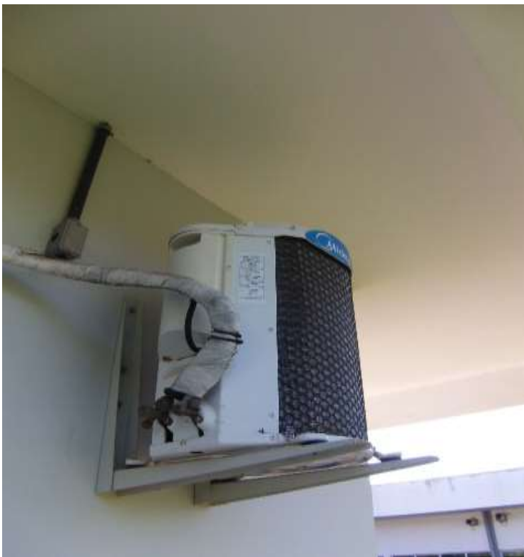
Figura 8 - Condensadoras Hotel Tecnológico
