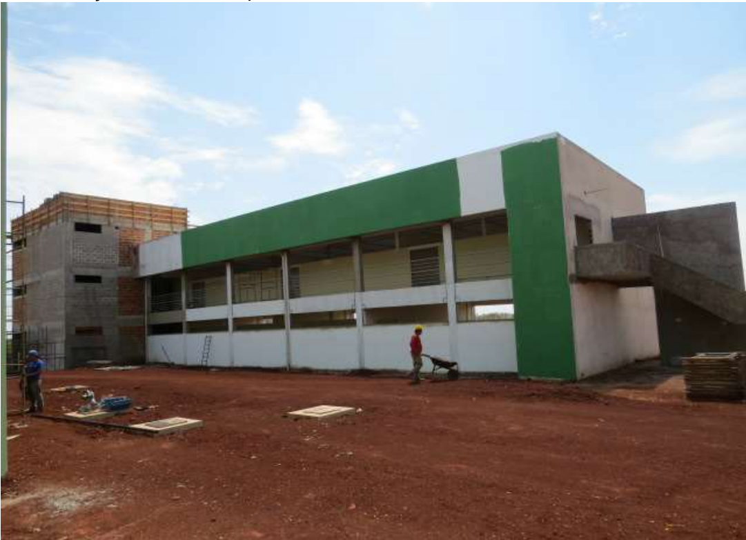
Foto 4 – Execução da obra Campus Dourados .
