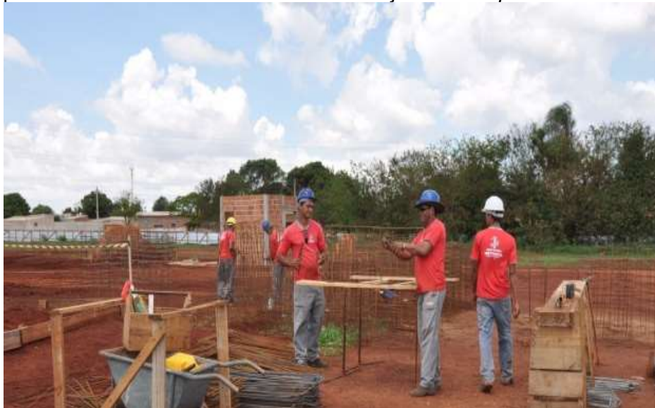
Foto 2 – Operários iniciando os trabalhos de construção do Campus Dourados .
