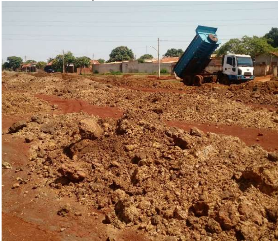
Foto 5 – Obras no acesso ao Campus Dourados .
