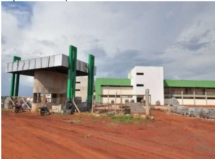
Foto 3 – Execução da obra Campus Dourados .
