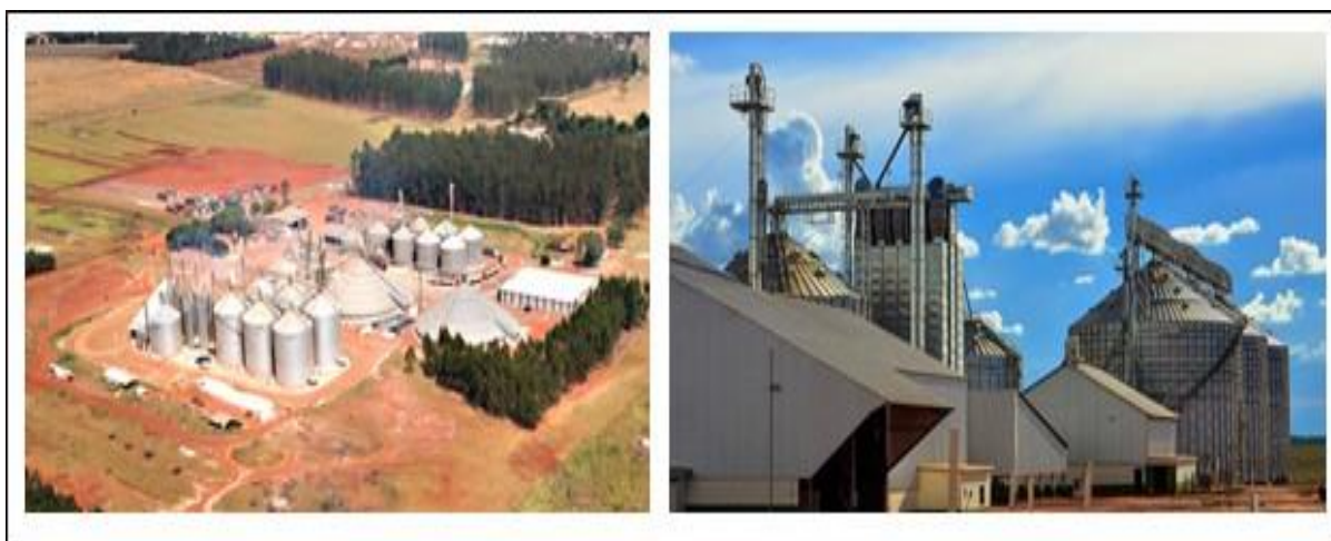
FIGURA 6 - Unidades para recebimento e armazenagem de grãos da COPASUL, município de Naviraí e Itaquirá, MS - 2016.
