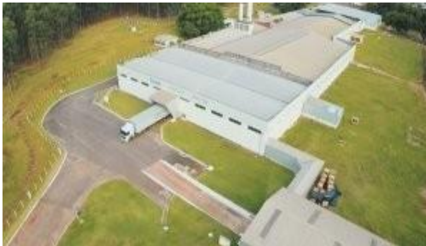
FIGURA 5 - Unidade industrial para fiação da COPASUL, município de Naviraí, MS - 2016
