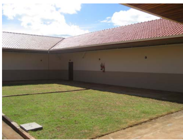
Figura 12 – Pátio interno - salas de aulas e laboratórios (B)
