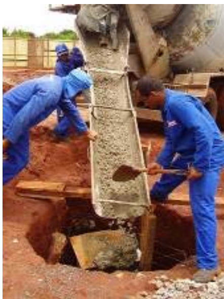
Figura 01 – Construção Bloco E
