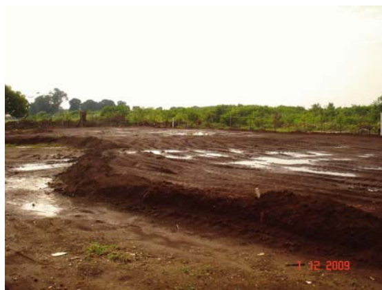
Figura 02 – Construção do bloco A, bloco C e cisterna
