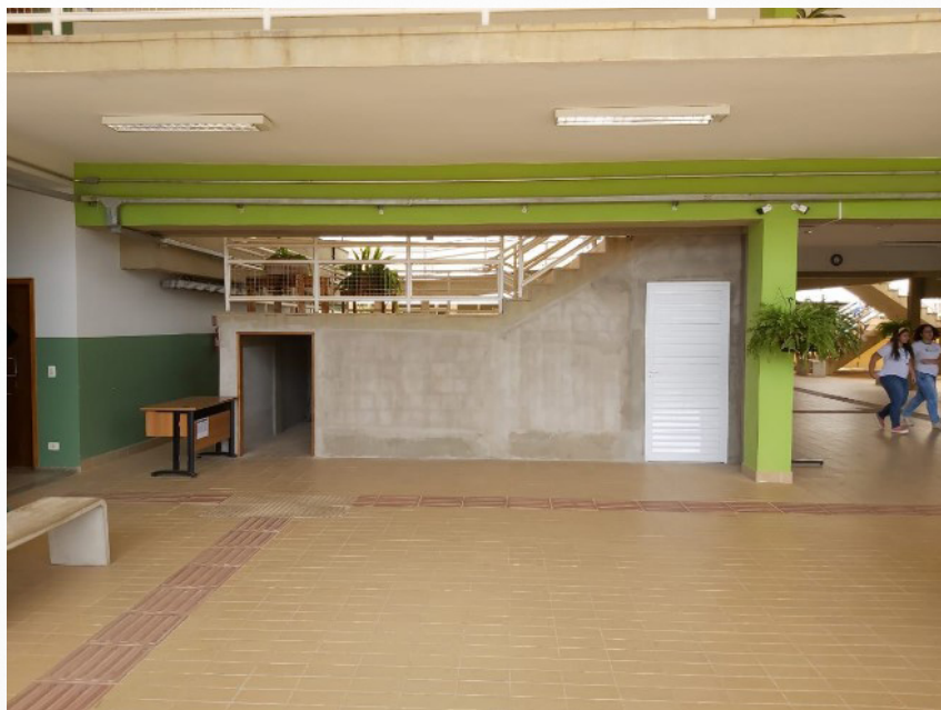
Imagens 11 e 12: Fechamento da escada para a criação da reprografia para os alunos e almoxarifado para armazenamento de materiais do campus. Fonte: Arquivo pessoal, 2019
